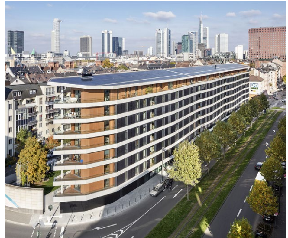
2. Aktiv-Stadthaus Speicherstraße HHS Planer + Architekten AG
